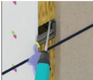
6) Visser en appui optimal la tête de vis grâce au bossage oblique
